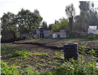
↑現地の被害状況
