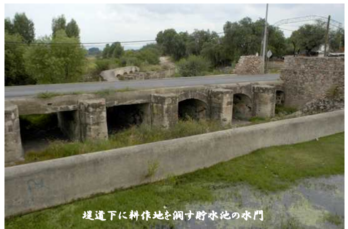
貯水池の壁を作る直線の堤道
